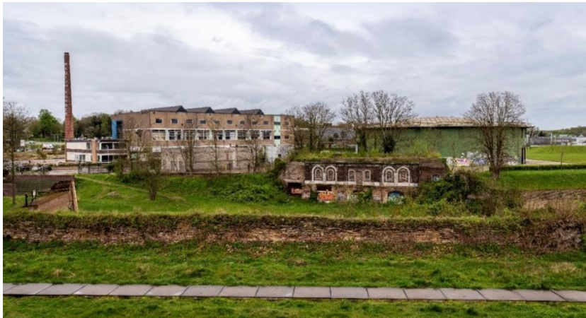
Kazemat-A met op de achtergrond het LAB-gebouw en Gashouder
